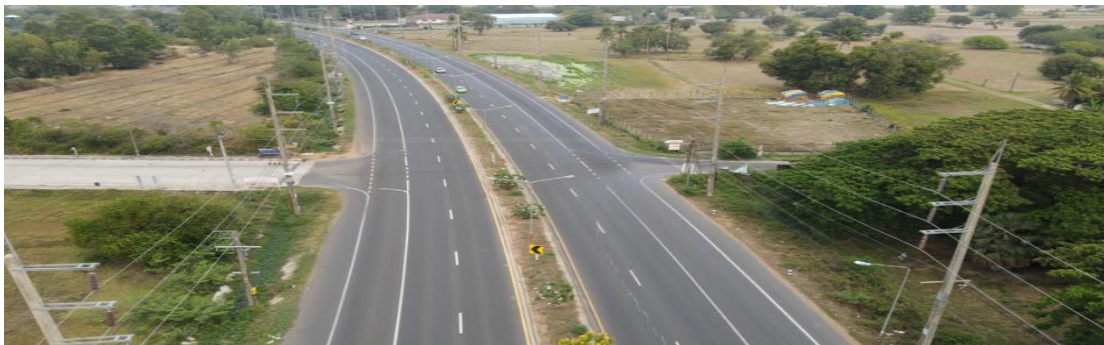
สภาพพื้นที่จุดเริ่มต้นโครงการ (ทางหลวงหมายเลข 294 บริเวณประมาณ กม.6+500)
