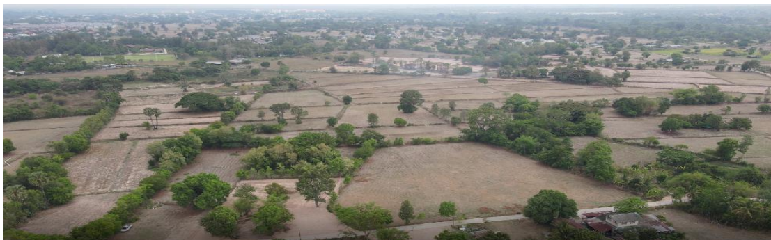
สภาพพื้นที่ตามแนวเส้นทางโครงการ บริเวณชุมชนบ้านบก รูปที่ 6-4 สภาพพื้นที่บริเวณช่วงแนวเส้นทางโครงการ (ต่อ)
